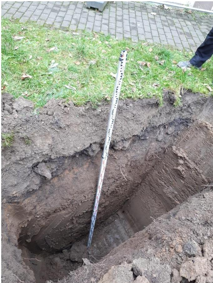
**Abb. 2:** Blick in den Schurf 1. Etwa 40 cm unter GOK ist eine Packlage erkennbar, die mit Mutterboden überschüttet wurde. Auch der obere Anteil der Auelehme bis etwa 1 m uGOK wurde umgelagert, bis zum Schurfende bei 2,6 m uGOK geht der braune Lehm in grau gefärbten Auelehm über.
