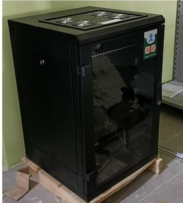
Es ist bei der Montage des Netzwerkschranks somit dafür zu sorgen, dass die Belüftungsanlage auf der Oberseite nicht abgedeckt ist.
